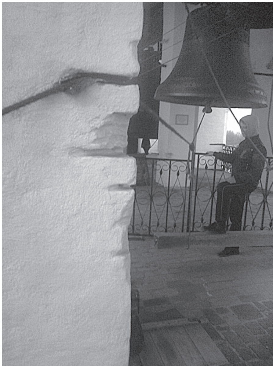
Ил. 1. Пазы-пропилы в кирпичной кладке для натяжения веревки от языка «Лебедя»
